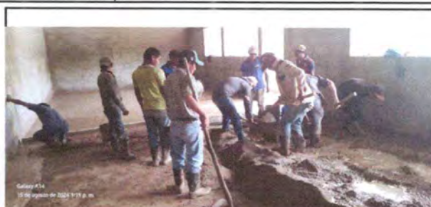
Foto 8: fundicion del piso dentro de la escuela.
