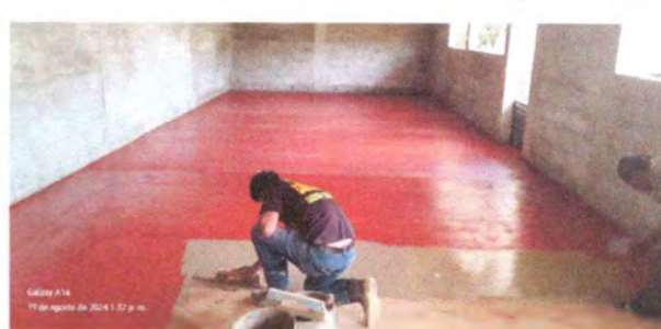
Foto 10: Alisado de piso con pintura
