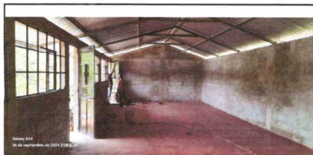
Foto 11: Instalacion de puertas y ventanas con su respectivo vidrio.
