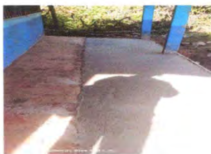
Foto 3: fundición del corredor del MODULO 3.
