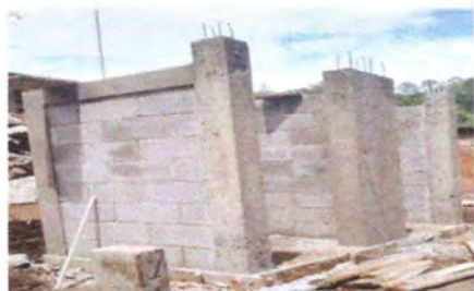
Foto1: MODULO 2. Levantado de bloks para inodoro.
