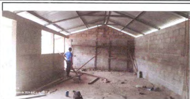
Foto7: colocacion de laminas.
