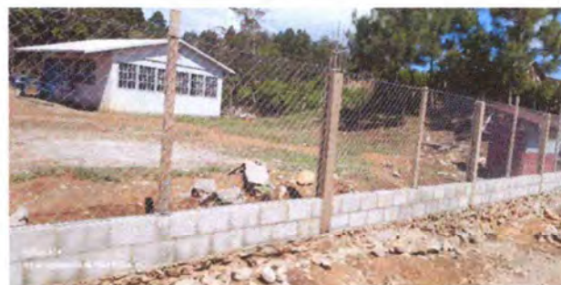
Foto 6: terminacion y colocacion de la malla del muro.
