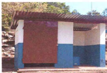
Foto 2: Terminacion de letrina.
