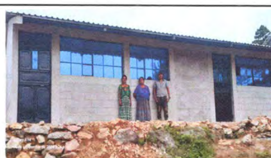
Foto 12: Finalizacion de la reparacion y construccion del aula.
