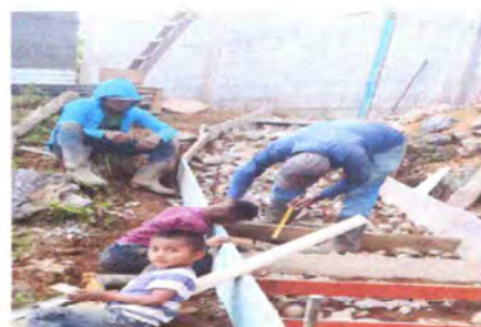
Foto 4: Iniciando con el trazo de las gradas de la escuela.
